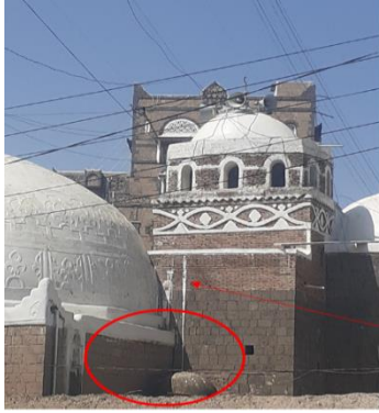
صورة لتوضيح تحويل اتجاه تصريف مياه الامطار نحو الجهة الشمالية وعمل فتحة الميزاب في الجدار الشمالي بدلاً عن الميزاب السابق الذي كان في الجهة الشرقية ويصب المياه فوق قبة الضريح مباشرة
